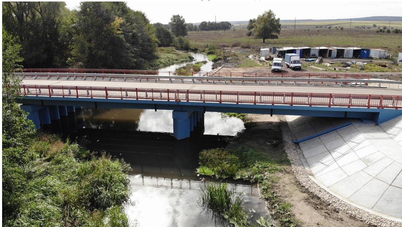
Автомобильный мост с. Шигоны
